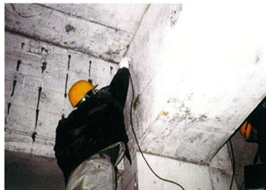
写真-1 音速測定状況
